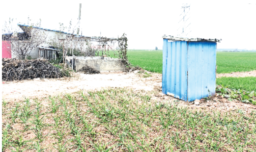
周口市城乡一体化示范区许湾街道办事处西翟桥村存在户外简易旱厕
