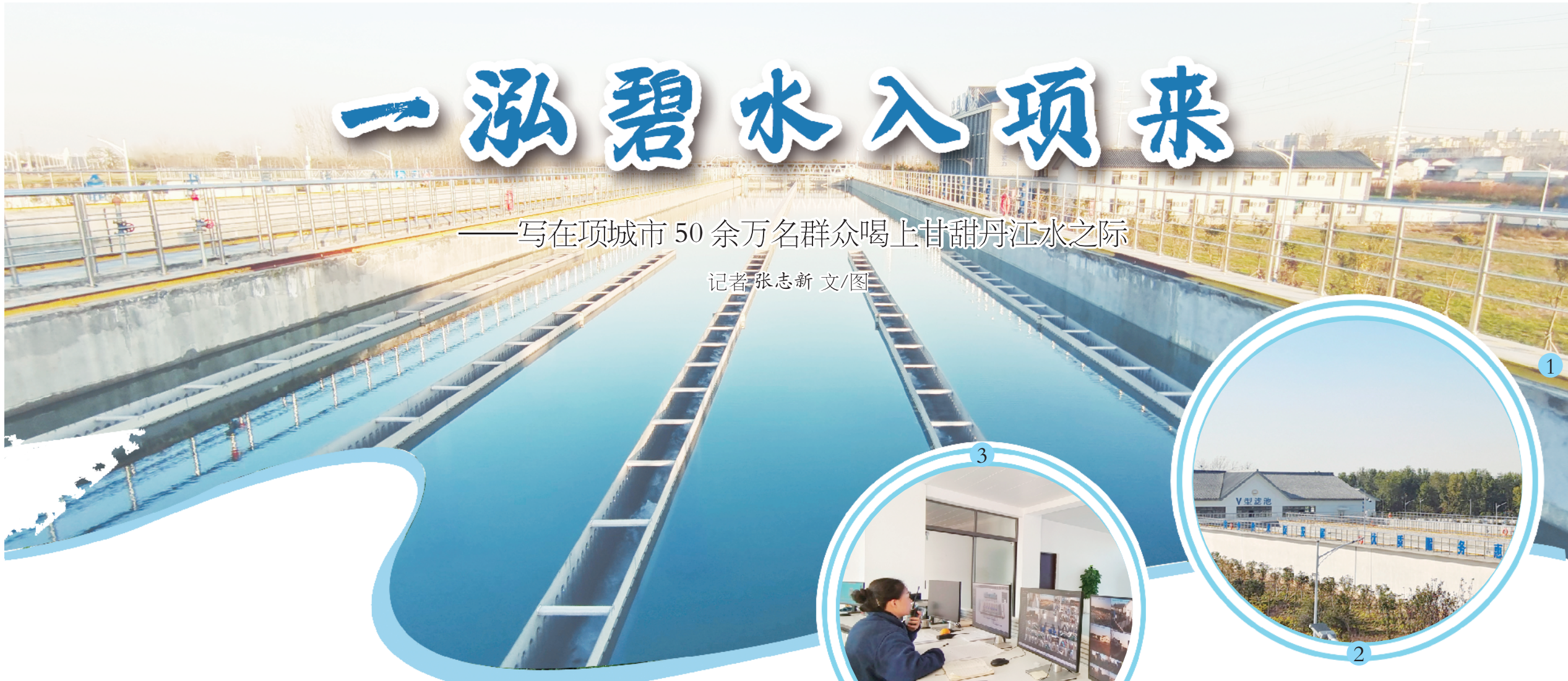
1 图为流入项城的一池丹江水。 2 图为项城市南水北调水厂一角。 3 图为项城市南水北调水厂智能化监测中心。
