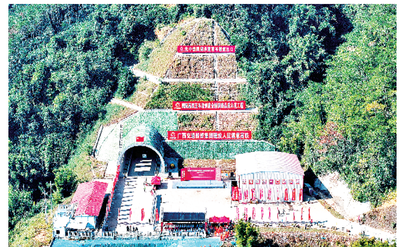
南深高铁玉岑段容岑隧道顺利贯通
